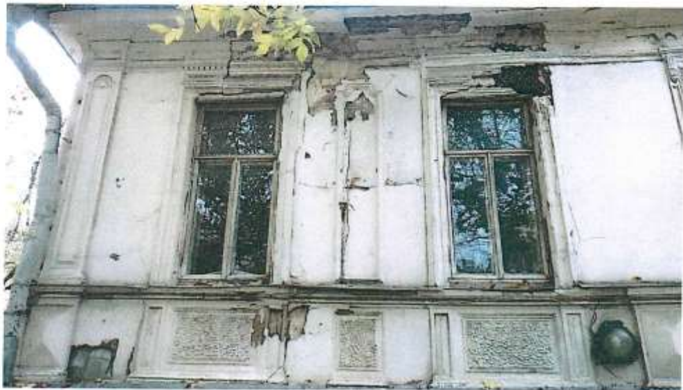
Фото № 4. Фрагмент главного (северного) фасада
