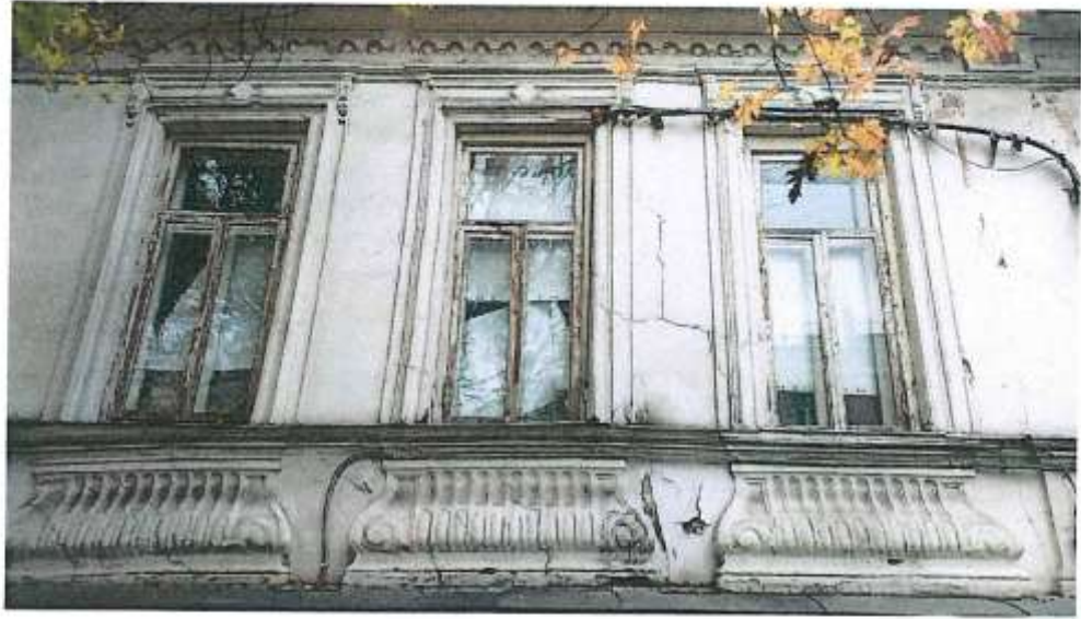
Фото № 3. Фрагмент главного (северного) фасада
